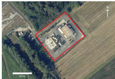
Fig. 1 : vue aérienne du site à numériser et modéliser (Geoportail.fr@2024)
