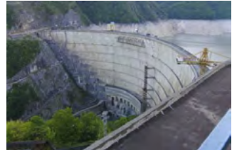
Fig. 1 : Vue du barrage
