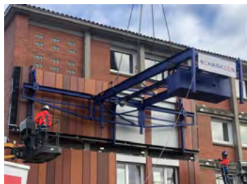
Fig. 1 : Pose de panneaux préfabriqués à l'ENVT (Le Moniteur@2023)
