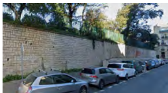
Fig. 1 : Exemple d'ouvrage à inspecter (source : Google Maps)
