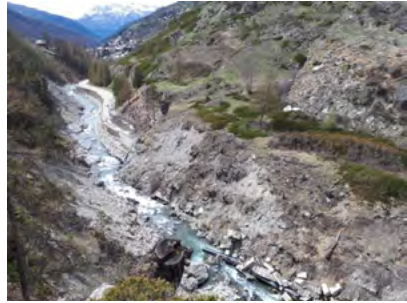
Figure 3. Destruction de la RD947 par le glissement.
