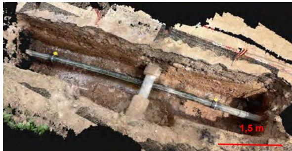
Fig. 2 : Résultat du nuage de point via PIX4Dcloud d'un réseau gaz. Tranchée de 1.5m de profondeur
