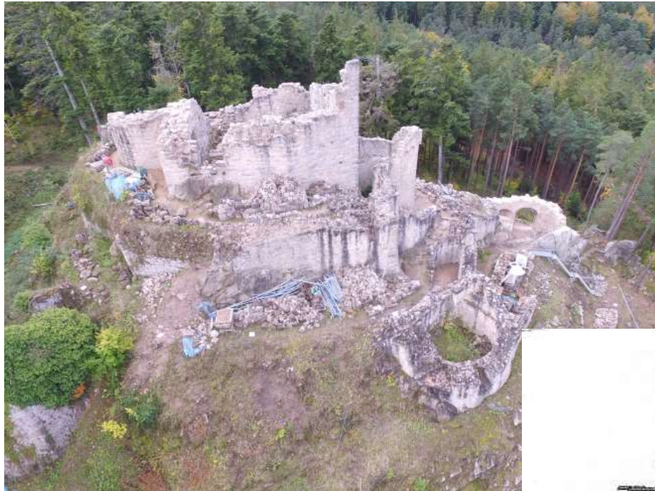
Château du Kagenfels (13 ème s.)
