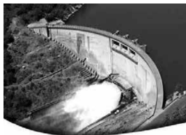
Figure 1 : Barrage des Monts d'Orb, vue aérienne [BRL@]
