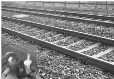
Image 1 : Prisme fixé directement sur un rail (chantier d'Heuilley-Cotton en France)
