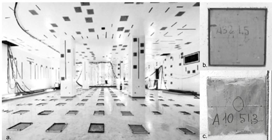
Figure 1 : a. Exemple d'environnement des platines (Iter ©) ; b. Platine avec délimitation géométrique ; c. Platine sans délimitation géométrique
